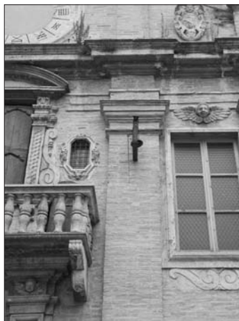
Montalto, chiesa di San Nicolò, particolare degli elementi lapidei applicati in facciata fra il 1647 e il 1652.
