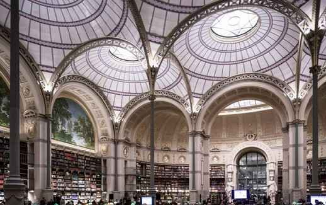
Henri Labrouste, Biblioteca Imperiale (poi Nazionale) , Parigi , 1859-68. Sala di lettura (volte su sostegni in ghisa) e depositi (ferro) di funzionalistico aspetto moderno.
